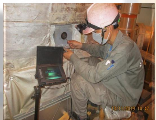
Nội soi đường ống, thiết bị áp lực
